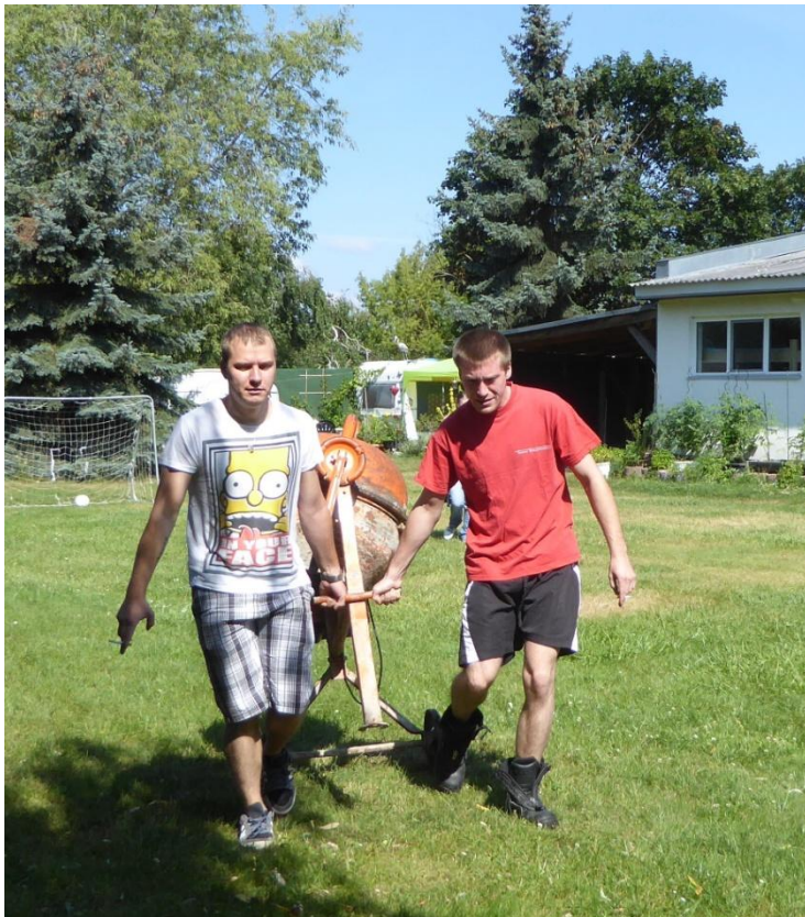
die jungen Väter sind für das Fundament der Rutsche zuständig
